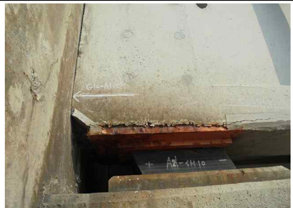
팽창줄눈 설치후 거더협착부 상태( '17년하)
