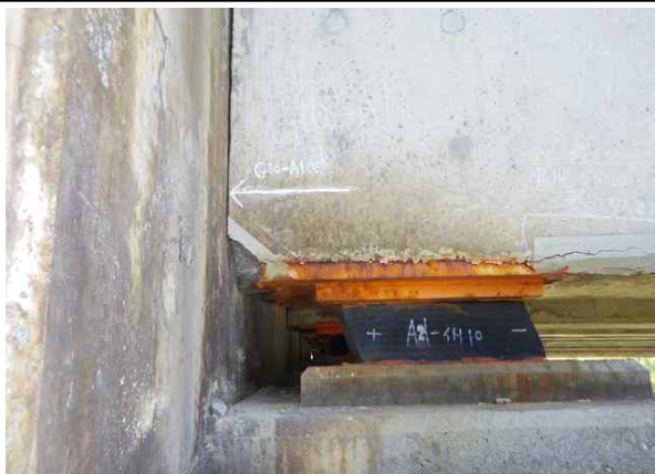
팽창줄눈 설치전 거더협착부 상태( '16년상)
